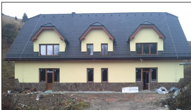
Obr. 8. Realizácia stavby na jeseň v roku 2018
