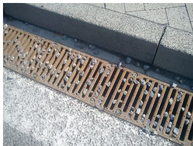
Chodníkový žľab – lapač splavenín
